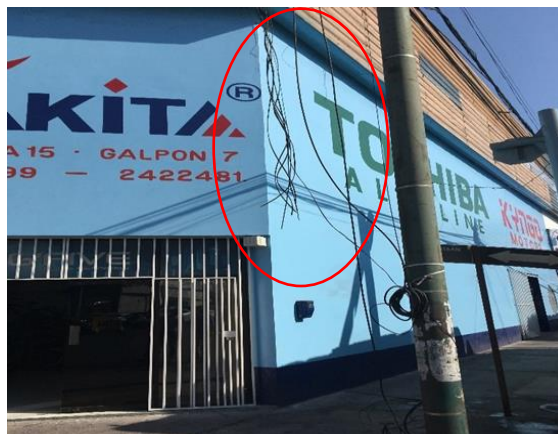
Fotografía 10. Tendido eléctrico descolgado
