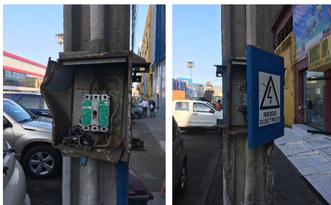
Fotografía 9. Tableros de la red eléctrica en áreas peatonales
