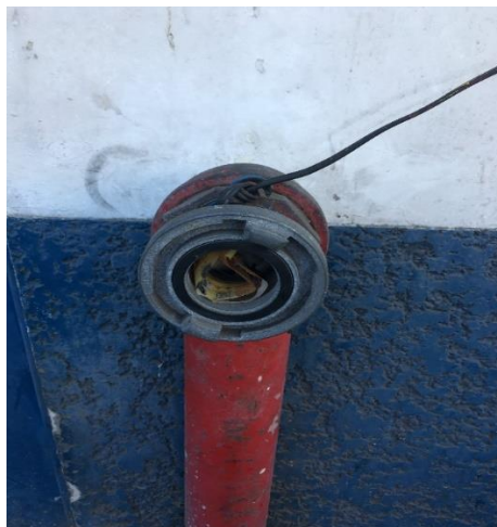
Fotografía 14. Elemento de la red seca hidrante en deficiente estado.
