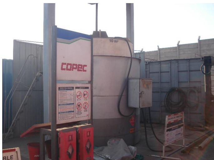
Fotografía 31. Depósito de combustible instalado en SITRANS.
