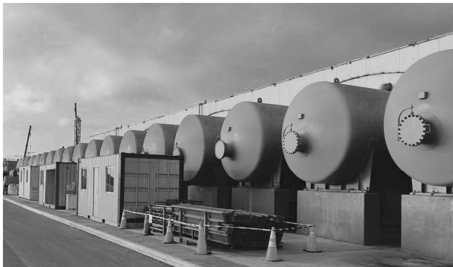
Figura 5. Configuración del módulo de filtros de arena en la planta desaladora de Aguas de Antofagasta (Antofagasta). Fuente: Autor
