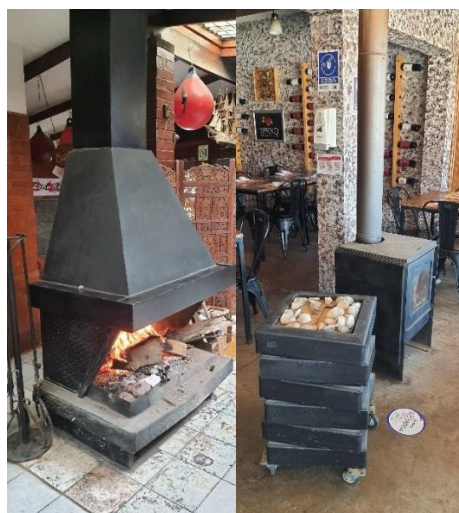
Ilustración 11: Chimeneas en salón comedor y reemplazo por estufa a biogás
