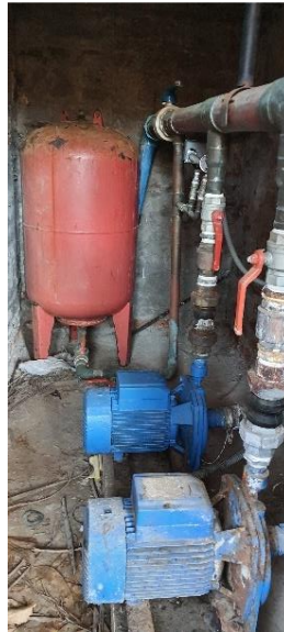
Ilustración 15: Sistema de presión (Hidropak) para agua potable y ACS
