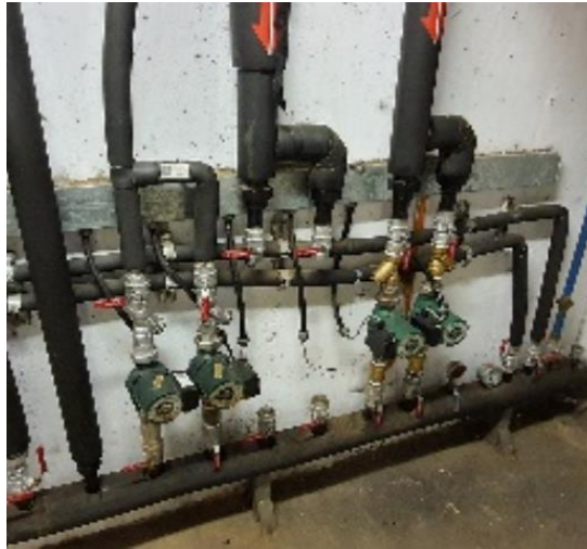
Ilustración 14: Bombas de circulación y tuberías con aislamiento
