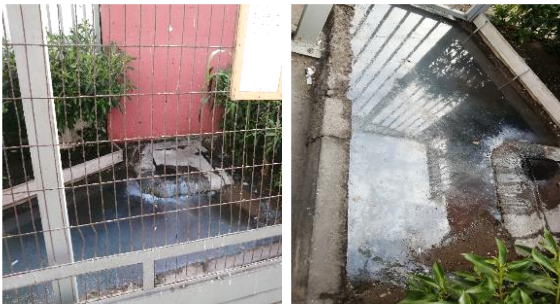
Fig. 14. Colapso y derrame de aguas servidas en zona de ingreso a Caleta Riquelme
